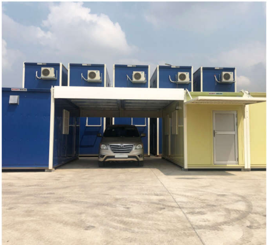
MÁI CHE 開放梁
